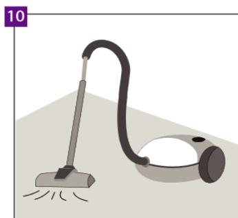
Veiller à ce que le sol soit sec, plat, stable et exempt de graisse et de produits chimiques. Les inégalités saillantes doivent être raclées et éliminées. Avant la pose, le sol doit être soigneusement balayé et dépoussiéré à l'aide d'un aspirateur, afin d'éliminer tous les débris. Il est indispensable de réparer les fissures les plus grandes et les imperfections les plus importantes du sol.
